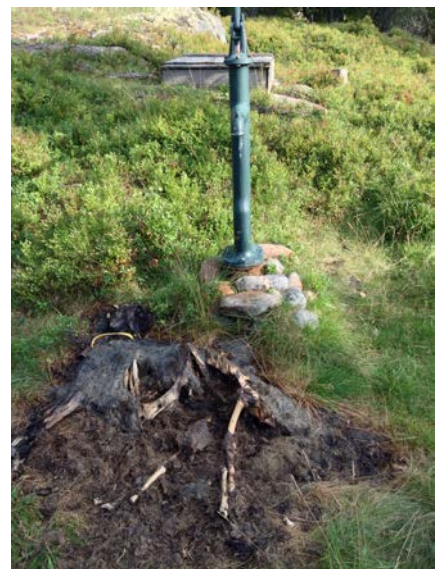
Figur 3.11: Sauekadaver rett ved en hyttebrønn. Er massene rundt brønnen tilstrekkelig tette til at den fortsatt har rent vann? (Foto: Jens Erik Pettersen)
