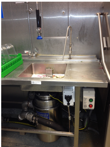
Figur 5.12: Uinnskrenket luftgap av type «AA» er den beste formen for beskyttelse mot forurensning fra andre systemer som forsynes med drikkevann. To typer luftgap; på bildet til venstre sikres luftgap mot matavfallskvern under vasken ved at spylevann kommer fra rør til høyre over vasken (Foto: Eyvind Andersen)
