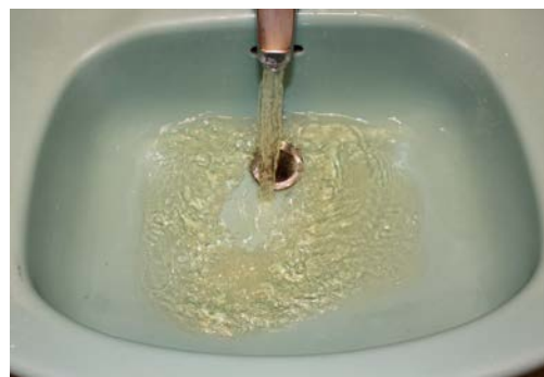
Figur 5.3: Drikkevann med synlig brun farge som skyldes korrosjon i ledningsnett på en offshoreinnretning (Foto: Eyvind Andersen)
