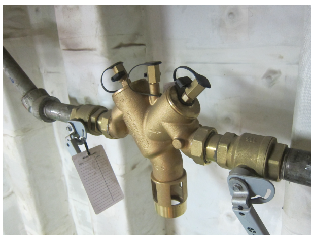
Figur 5.13: Andre væskesystemer bør ikke forsynes med drikkevann. Dersom dette ikke er til å unngå, gir brutt forbindelse eller en ventil av type "BA" best beskyttelse. Legg merke til de tre testportene på ventilens topp. En slik ventil må utstyres både med forfilter og stoppventiler som muliggjør testing (Foto: Eyvind Andersen)
