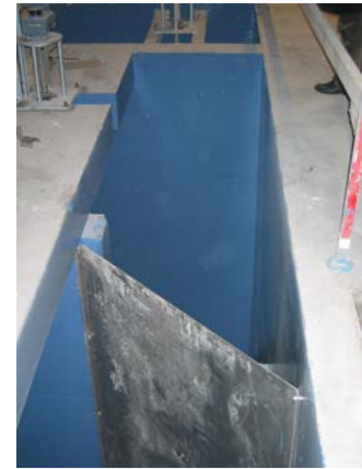
Figur 4.3: Flokkuleringskammer (Foto: Jens Erik Pettersen)
