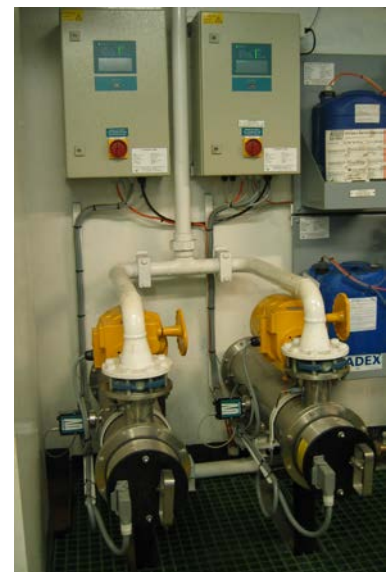
Figur 4.14: UV-anlegget på bildet består av to bestrålingskamre som begge er utstyrt med UV-sensor på siden og manuell renseanordning foran, hvor innvendige «viskere» dras frem og tilbake med håndtaket foran. Øverst på bildet er kontrollskapene (Foto: Bjørn Løfsgaard).
