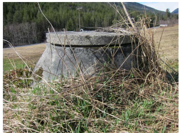
Figur 3.7: Øverste kumring i løsmassebrønn. Brønnen er gravd gjennom et tett, beskyttende lag og mates med grunnvann (Foto: Eyvind Andersen)
