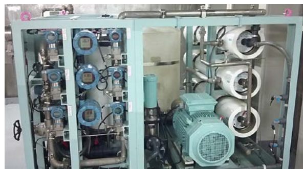
Figur 4.19: Til venstre på bildet ser man tre omvendt osmosemembraner som brukes til å lage drikkevann av sjøvann. Slike membraner har ofte en porestørrelse på rundt 0,1 nm (Foto: Eyvind Andersen)
