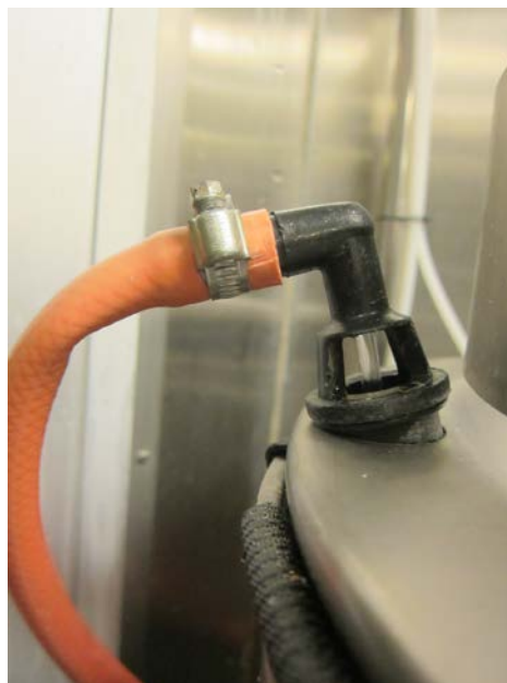
Figur 5.12: Uinnskrenket luftgap av type «AA» er den beste formen for beskyttelse mot forurensning fra andre systemer som forsynes med drikkevann. To typer luftgap; på bildet til venstre sikres luftgap mot matavfallskvern under vasken ved at spylevann kommer fra rør til høyre over vasken (Foto: Eyvind Andersen)
