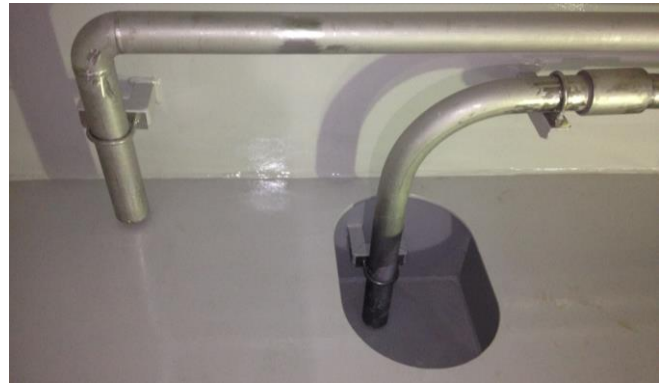
Figur 9.4: Tankens sugerør (til venstre) er hevet litt fra tankens bunn, mens dreneringsrør nede i sumpen i midten gjør det lett å tømme tanken for vann og skittent vaskevann (Foto: Eyvind Andersen)
