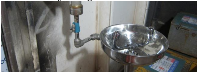
Figur 9.15: På grunn av lavere (og laminær) vannstrøm i det grove røret enn det lille røret som forsyner øyespylestasjonen, vil biofilm lettere vokse i det grove røret (Foto: Eyvind Andersen)
