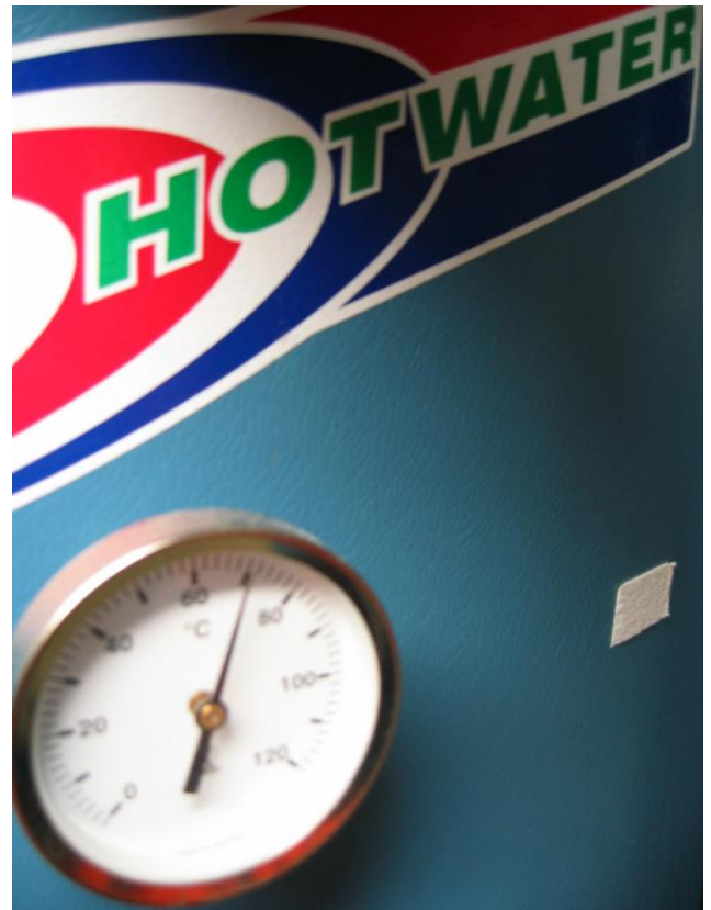
Figur 9.21: Legionella kan forebygges ved å holde kaldt vann kaldt og varmt vann varmt (Foto: Eyvind Andersen)
