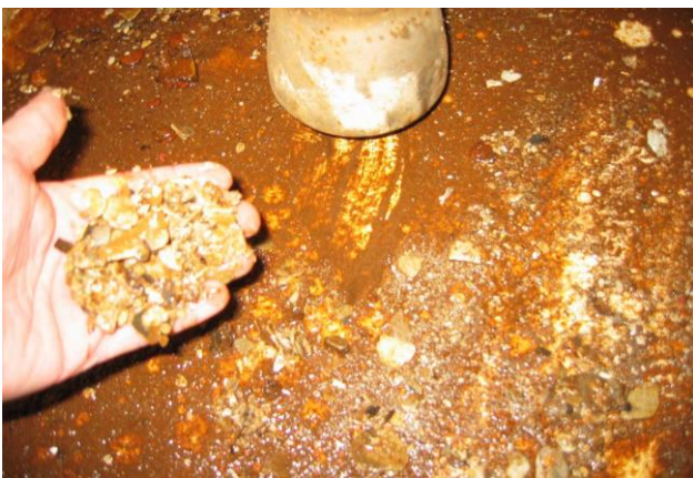
Figur 8.4: Etter bunkring og i urolig vær kan partikler og slam i drikkevannstanker bli virvlet opp og sugd inn i drikkevannsnettet, der de reduserer effekten av UV-anlegget (Foto: Bjørn Løfsgaard)
