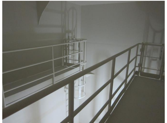
Figur 9.2: Adkomstplattformer legger til rette for vedlikehold i tanker som er over 4 meter høye. Det er viktig å minimere innvendige strukturer i tanken for å lette sirkulasjon og vedlikehold. Tanken sirkuleres ved å ha innløp øverst i ene hjørnet av tanken mens utløpet er nederst i motsatt hjørne (Foto: Eyvind Andersen)
