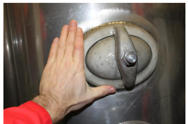
Figur 5.5: Alkaliseringsfiltre, trykktanker og varmtvannsbereidere leveres ofte med adkomsthull som er så små at de i praksis ikke er mulige å rengjøre (Foto: Eyvind Andersen)
