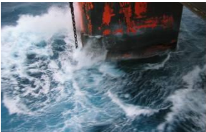
Figur 6.2: Rundt plattformbeina er det stor turbulens. Sjøvannsinntak plasseres der forurensningsrisikoen er minst (Foto: Eyvind Andersen)
