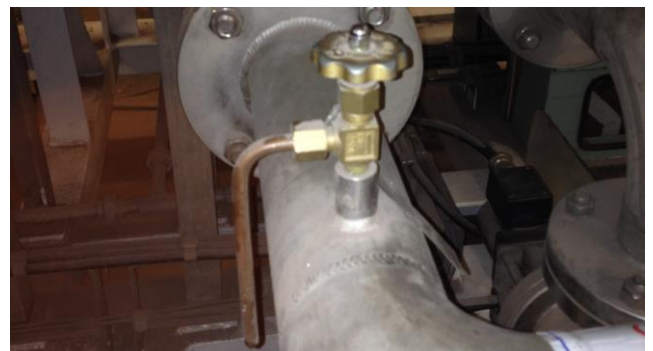
Figur 5.8: Kort og selvdrenerende prøvepunkt med liten rørdiameter. Kort avstand fra hovedrør til ventil gjør at stillestående vann unngås. Ved å plassere uttaket på oversiden unngår man at partikler legger seg i prøvepunktet. Rørenden kunne med fordel vært kortere for å lette desinfeksjon av prøvepunktet (Foto: Eyvind Andersen)
