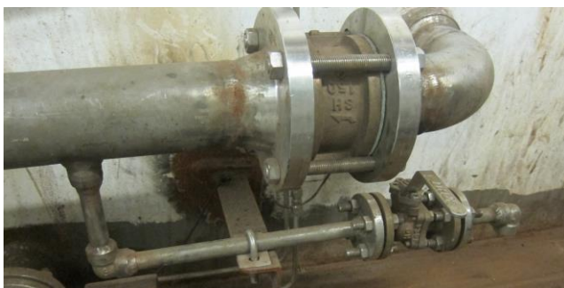
Figur 9.14: Prøvepunktøret er feildesignet da prøverøret er unødvendig langt og alt for grovt. Uttak på rørets underside er i tillegg uheldig da dette kan føre til oppvekst av biofilm grunnet smuss og partikler som ansamles, og vannprøvene blir derfor ikke representative (Foto: Eyvind Andersen)
