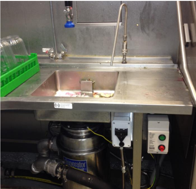
Figur 9.16: Uinnskrenket luftgap av type «AA» er den beste formen for beskyttelse mot forurensning fra andre systemer som forsynes med drikkevann. Her skjer vanntilførsel til matavfallskvern via rør til høyre over vasken (Foto: Eyvind Andersen)
