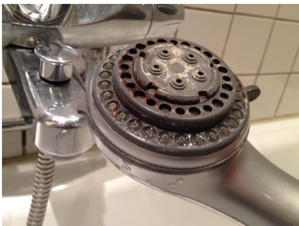
Figur 9.24: En omfattende biofilm kan oppstå der renholdet er mangelfullt. I slik biofilm er det gode voksemuligheter for mikrober (Foto: Eyvind Andersen)
