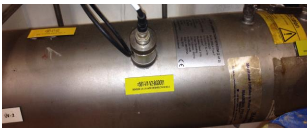
Figur 8.8: UV-sensoren er her plassert oppå UV-kammeret (Foto: Eyvind Andersen)
