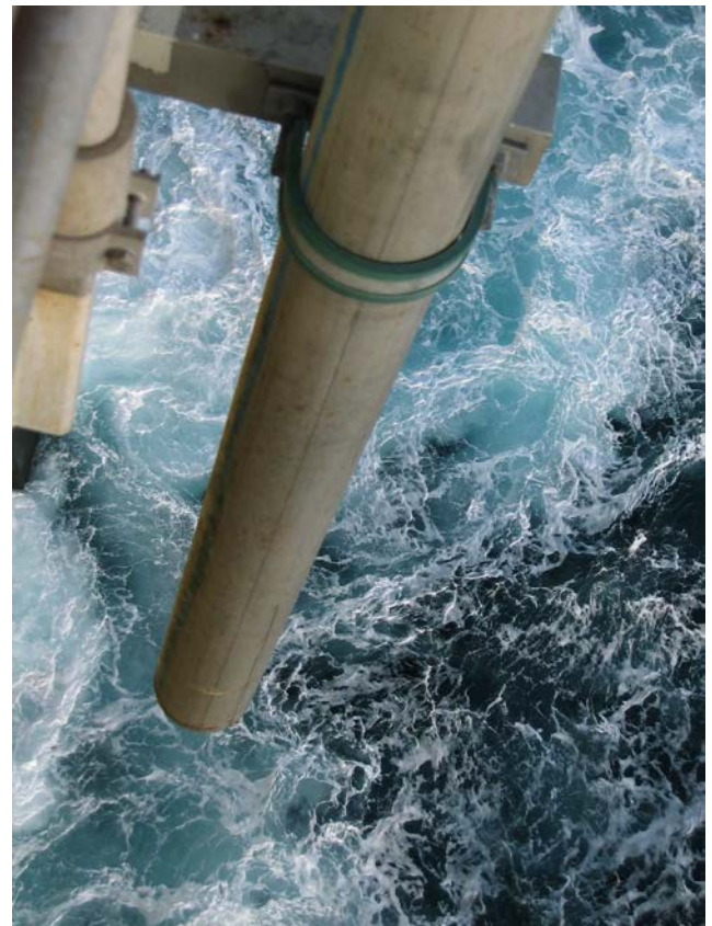
Figur 7.9: Når spylorøret er av samme dimensjon som bunkringsslangen får man spylt med fullt trykk (Foto: Eyvind Andersen)
