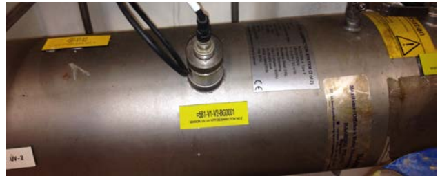
Figur 8.8: UV-sensoren er her plassert midt på UV-kammeret (Foto: Eyvind Andersen)
