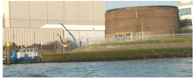
Figur 7.2: Ved at man på forsyningsbasen har en vanntank som fylles langsomt, men som gir mulighet for hurtig påfylling til forsyningsbåten unngår man spyleeffekt i ledningsnett på land, og får dermed renere vann (Foto: Eyvind Andersen)
