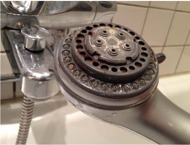
Figur 9.24: En omfattende biofilm kan oppstå der renholdet er mangelfullt. I slik biofilm er det gode voksemuligheter for mikrober (Foto: Eyvind Andersen)
