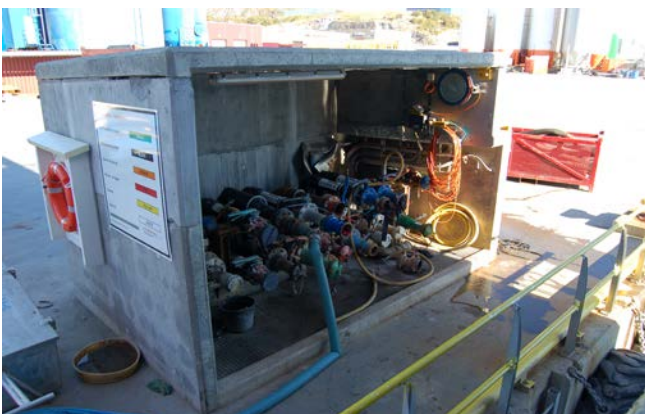
Figur 7.1: Bunkringsstasjon på forsyningsbase. Vann kan være forurenset før det kommer ut til basen, og ved dårlige rutiner på forsyningsbasen kan både bunkringstilkoplinger og -slanger være forurenset (Foto: Eyvind Andersen)
