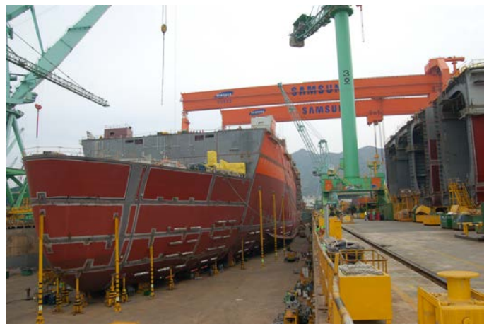
Figur 2.1: Bilde av innretningen Skarv tatt på verftet (Foto: Eyvind Andersen)
