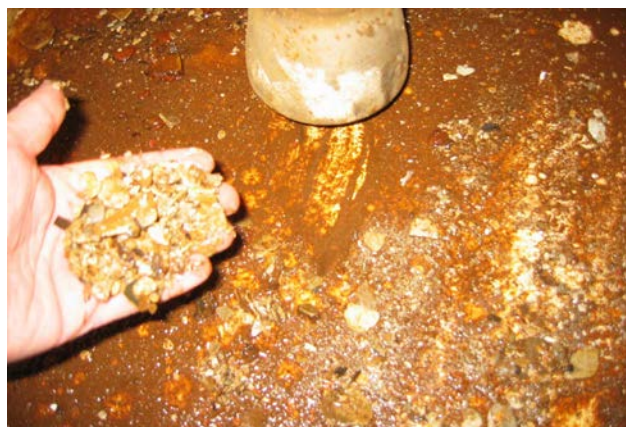
Figur 8.4: Etter bunkring og i urolig vær kan partikler og slam i drikkevannstanker bli virvlet opp og sugd inn i drikkevannsnettet, der de reduserer effekten av UV-anlegget (Foto: Bjørn Løfsgaard)
