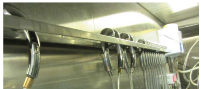
Figur 9.23: Dusjslanger og -hoder er risikopunkter for legionellaoppvekst grunnet lav vanntemperatur etter blandebatteri kombinert med at vannet står stille i stikkrør. Her forebygges oppvekst ved at utstyret får henge og tørke (Foto: Arild Tolo)
