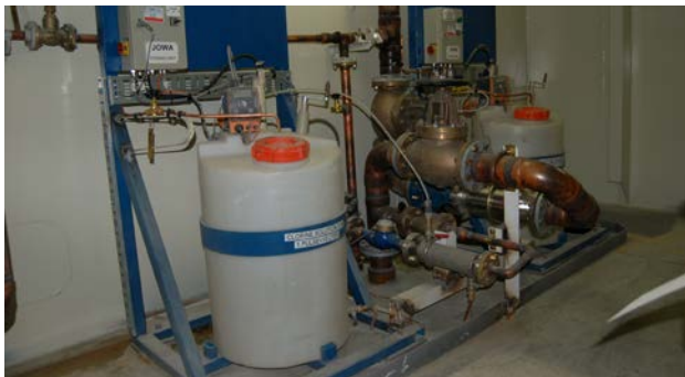
Figur 5.7: Lett tilgjengelig klortank som er godt merket og sikret (Foto: Eyvind Andersen)
