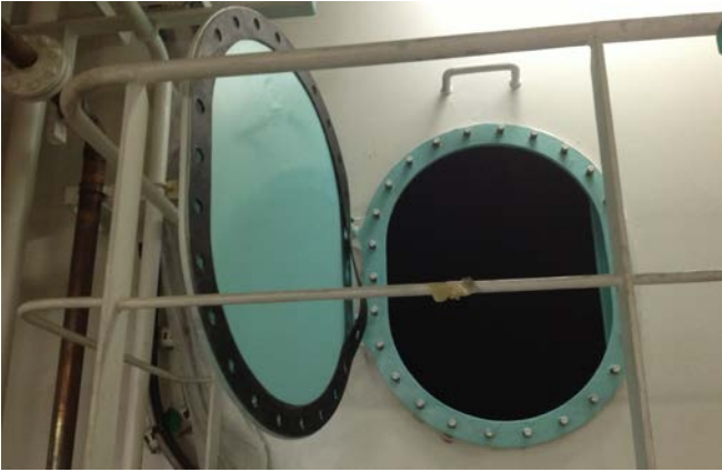
Figur 9.5: Bildet viser et lett tilgjengelig mann hull for drikkevannstank (Foto: Eyvind Andersen)
