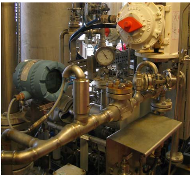
Figur 6.7: En konduktivitetmåler sørger for at produsert vann automatisk sjekkes, og dumpes dersom grensen på 6 mS/m overskrides (Foto: Eyvind Andersen)
