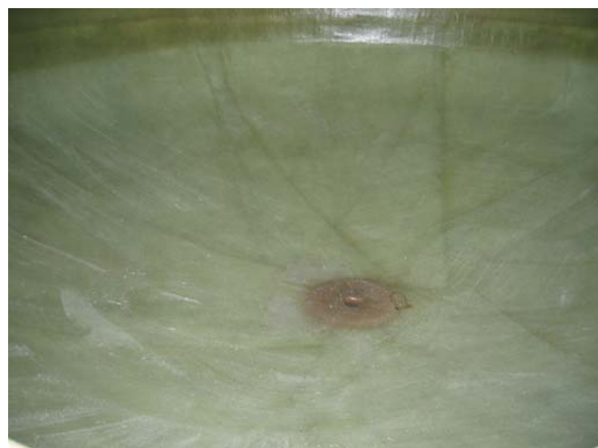
Figur 9.2: Lett drenerbar drikkevannstank uten innvendige spant og med buet bunn (Foto: Bjørn Løfsgaard)
