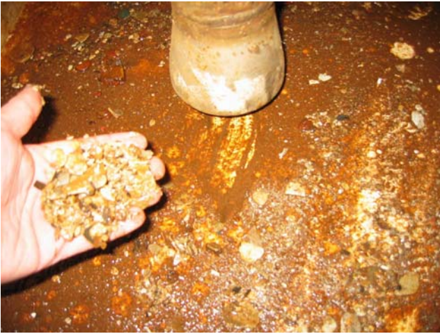
Figur 8.4: I urolig vær kan partikler og slam i drikkevannstanker bli virvlet opp og sugd inn i drikkevannsnettet, der de reduserer effekten av UV-anlegget (Foto: Bjørn Løfsgaard)
