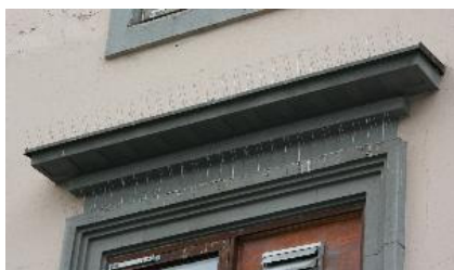
Fuglesikringsutstyr i form av metallpigger som hindrer fugler i å finne hvile- og hekkeplasser på bygninger.
