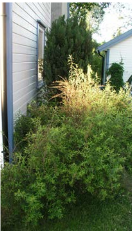
Vegetasjon der rotter, mus og fugler kan gjemme seg bør ikke stå nær husveggen.
